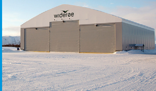
Hangar-Mehrfachtor in Norwegen, 36x11 m
