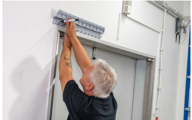
2. Löcher anzeichnen und bohren
