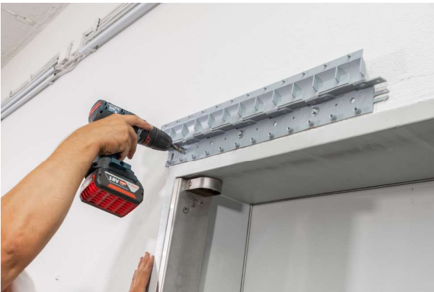
3. Schiene befestigen
